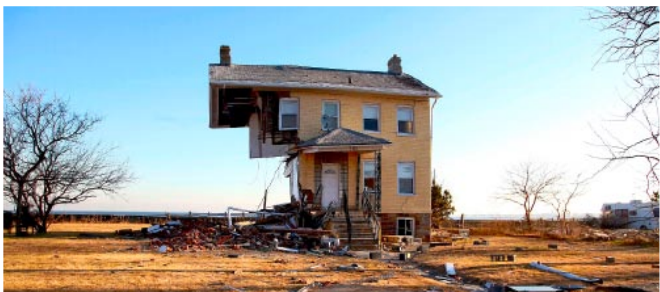
Die Behebung der Verwüstungen des Sturmtiefs «Sandy» – hier an einem Haus in New Jersey – wird rund 50 Mrd. $ kosten.
