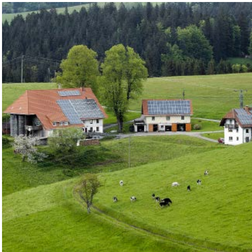
Emissionsfreie Gebäudetechnik soll das neue Geschäft von Edisun werden.
