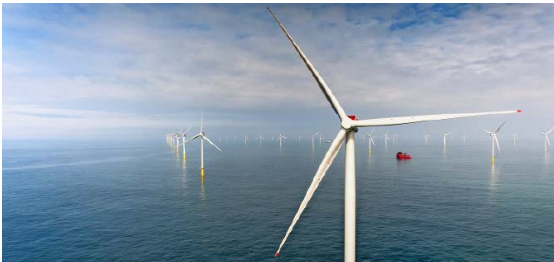
Die 1,5 Mrd. £ teure Windfarm Dudgeon Offshore von Statoil: Sie nimmt noch dieses Jahr ihren Betrieb auf und wird 410 000 Haushalte in England mit Strom versorgen.
