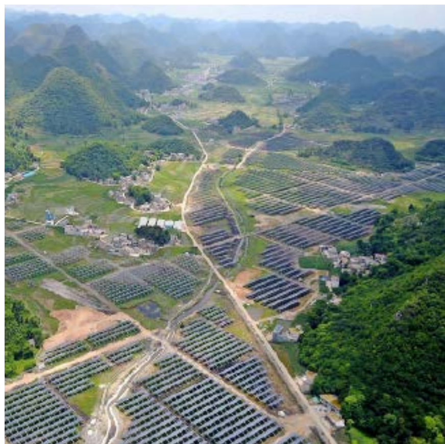
Solaranlagen auf Treibhausdächern in Yang Fang in der chinesischen Provinz Guizhou.
