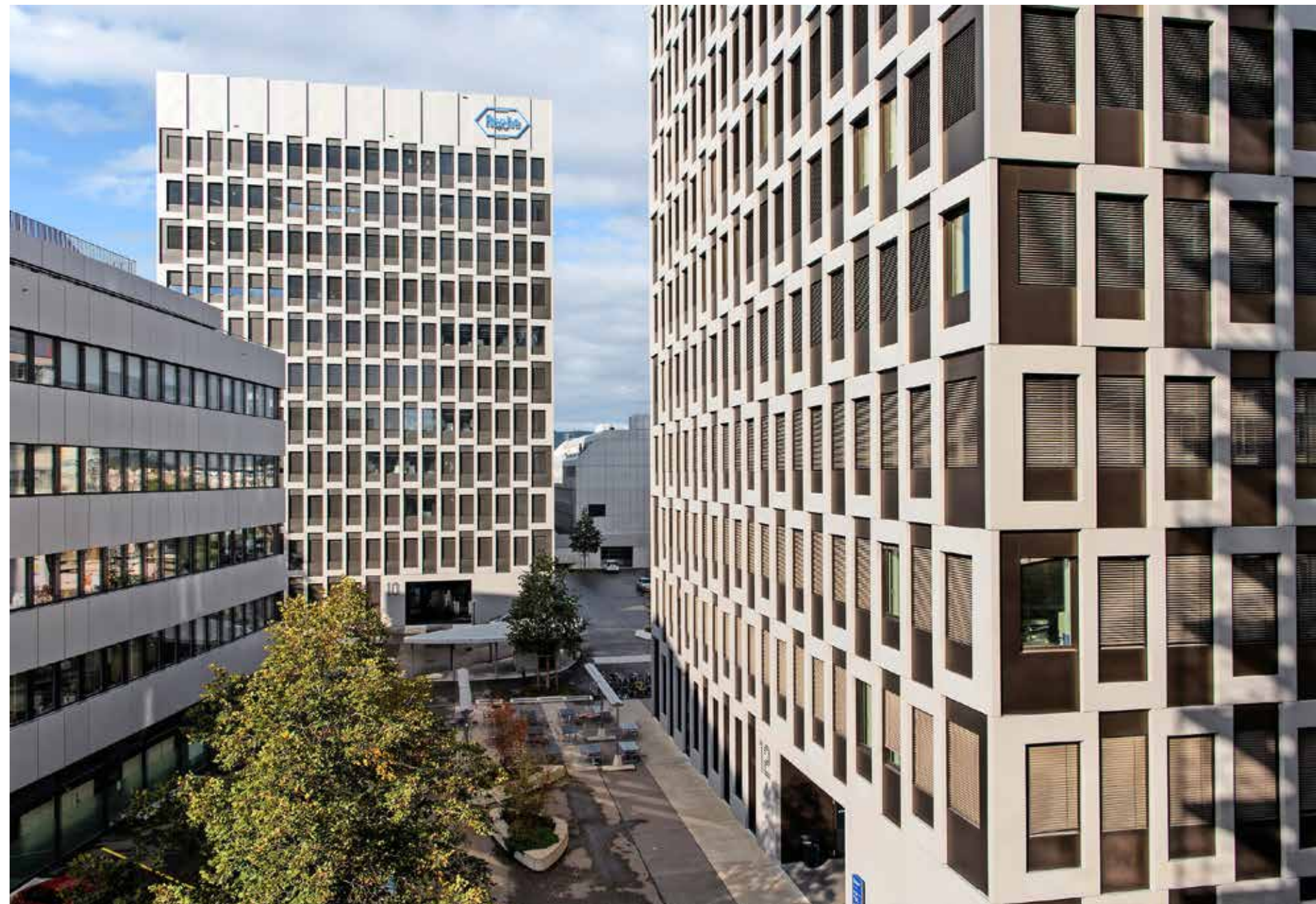
Der Bio-Technopark verzeichnet eine grosse Nachfrage nach Raum. Um sie zu befriedigen, wurden bereits zwei Hochhäuser erstellt. Ein drittes befindet sich im Bau.
